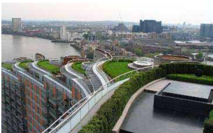
Das Projekt New Providence Wharf in London besticht durch seine kaskadenartigen Dachgärten mit Blick auf die Themse. © IGRA
